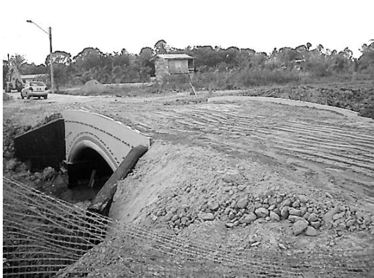
Рисунок 3. Этапы строительства бетонно-композитного моста фирмой Advanced Infrastructure Technologies Inc.
