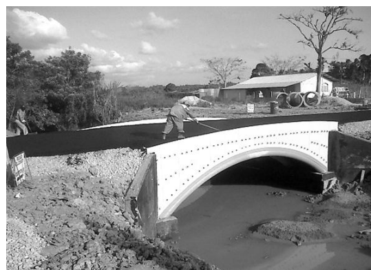
Рисунок 3. Этапы строительства бетонно-композитного моста фирмой Advanced Infrastructure Technologies Inc.
