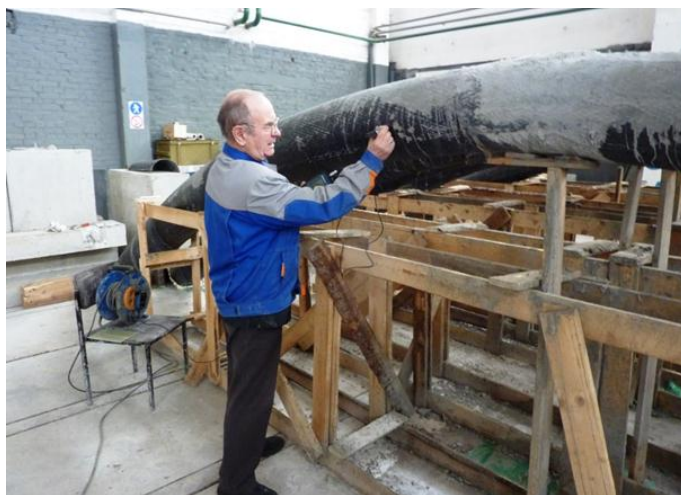
Рис. 5. Рабочий момент контроля качества заполнения арочного элемента бетоном
