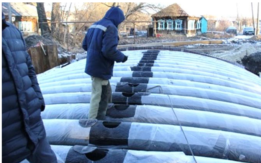
Рис. 6. Подготовительные работы перед бетонированием арочных элементов
