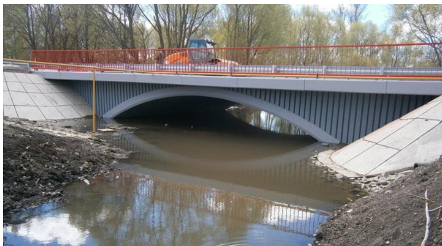
Рис. 7. Готовый арочный мост
