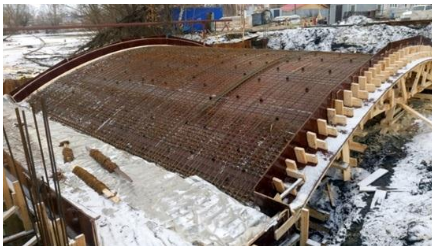
Рис. 4. Арматурный каркас нижней защитной оболочки арочных элементов
