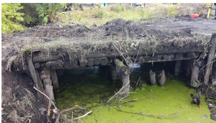
Рис. 2. Вид старого моста перед началом строительства
