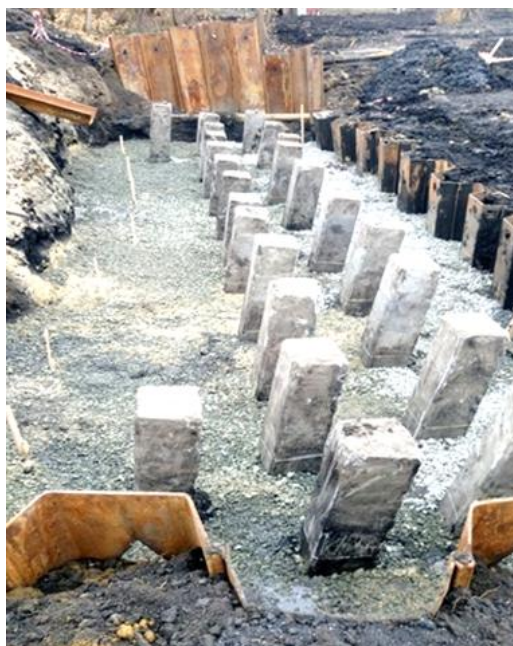
Рис. 3. Конструкция фундамента будущего арочного моста
