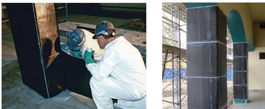
Рис. 1. Армирование бетонных конструкций углеродной лентой
