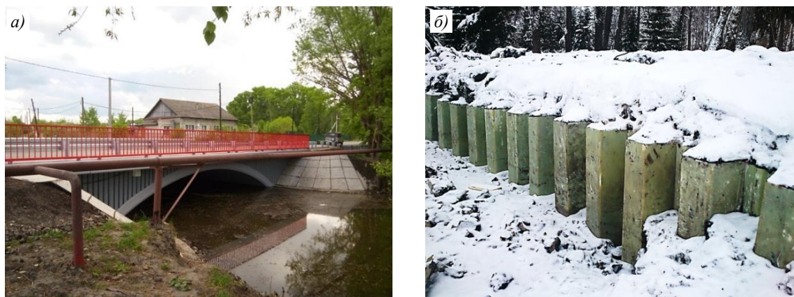
Рис. 3. Арочный мост, изготовленный с применением углепластиковых арочных элементов и листов стеклопластикового профилированного настила (а), и укрепление береговой линии водоема с использованием стеклопластиковых шпунтов (б)
