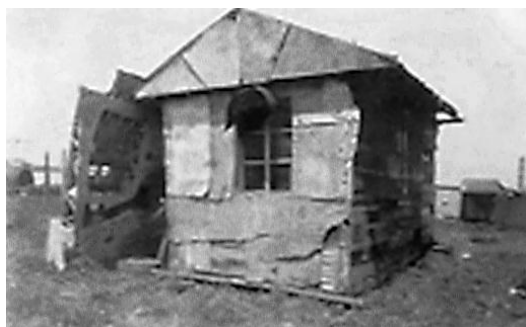
Первая постройка Батумской научно-исследовательской станции (1943)
