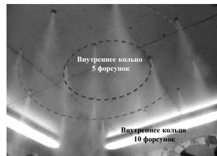
Рис. 2. Фото форсунок, расположенных в потолке холодильной камеры для создания ледяного облака
