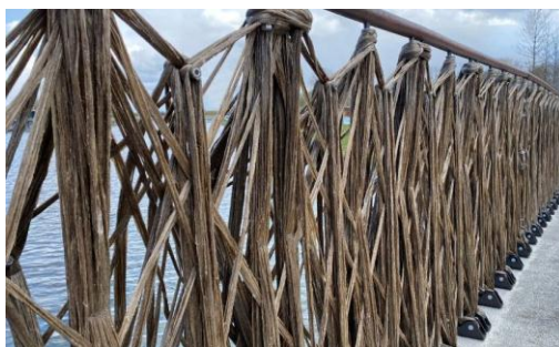
Рис. 9. Декоративные перила моста из полимерного композита на основе льна [39]
