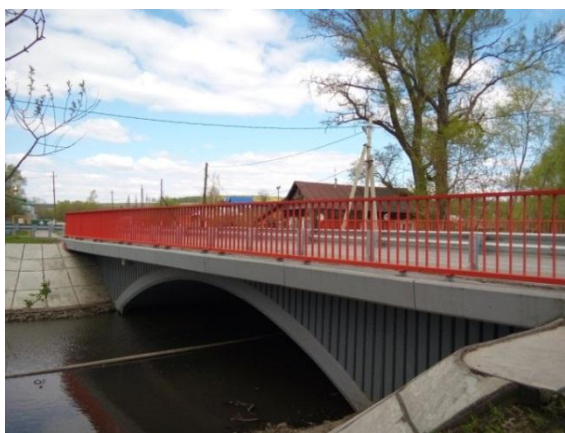
Рис. 1. Автомобильный арочный двухполосный мост в р. п. Языково Корсунского района Ульяновской области
